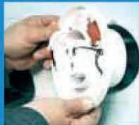
Připojte elektrické vodiče
